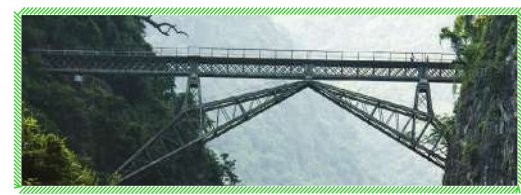
Viaduc du Faux-Namti, Chine, 1910 (voir page 16)
