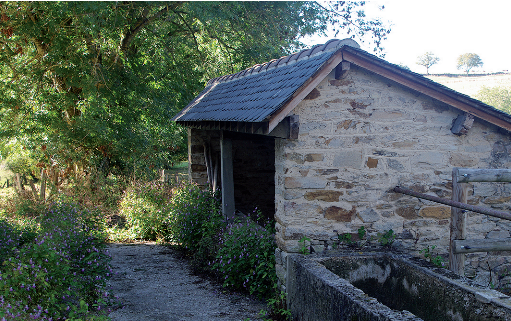
Photo du lavoir de Gramond situé route de Boussac. / Croquis du lavoir (Direction des eaux et du génie rural, 1933).
