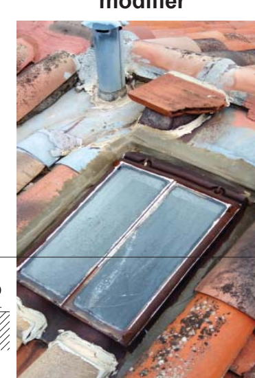
Vues sur les Velux existants à remplacer par fenestres "patrimoine" 80/120 sens de la pente pour le plus long coté, chevretres à reprendre pour les 4 faces coté rue Ferdinand Fabre coté cour interieure voisine
