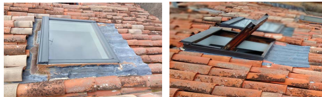
Vues sur les Velux existants à remplacer par fenetres "patrimoine" 80/120 sens de la pente pour le plus long coté, chevretres à reprendre pour les 4 faces coté rue Ferdinand Fabre coté cour interieure voisine
