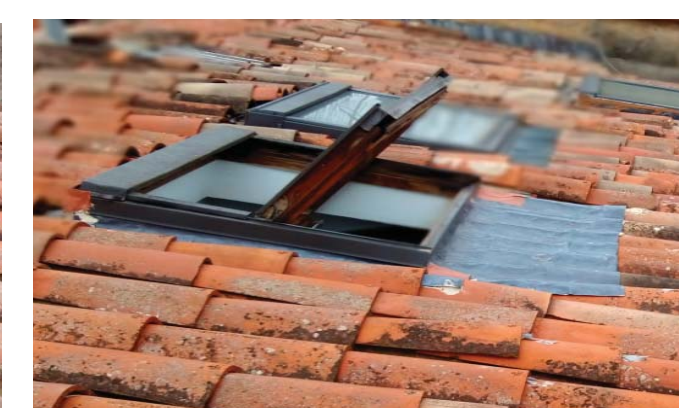
Vues sur les Velux existants à remplacer par fenestres "patrimoine" 80/120 sens de la pente pour le plus long coté, chevretres à reprendre pour les 4 faces coté rue Ferdinand Fabre coté cour interieure voisine
