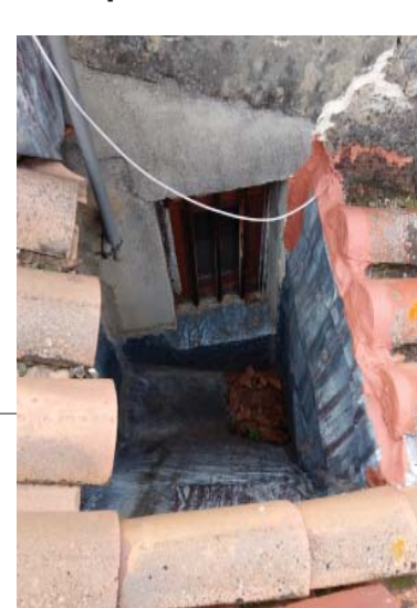
Vues sur les Velux existants à remplacer par fenestres "patrimoine" 80/120 sens de la pente pour le plus long coté, chevretres à reprendre pour les 4 faces coté rue Ferdinand Fabre coté cour interieure voisine
