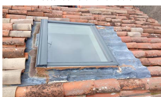
Vues sur les Velux existants à remplacer par fenestres "patrimoine" 80/120 sens de la pente pour le plus long coté, chevretres à reprendre pour les 4 faces coté rue Ferdinand Fabre coté cour interieure voisine
