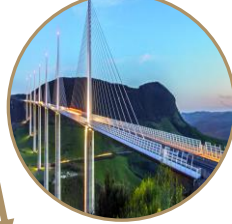
Viaduc de Millau
