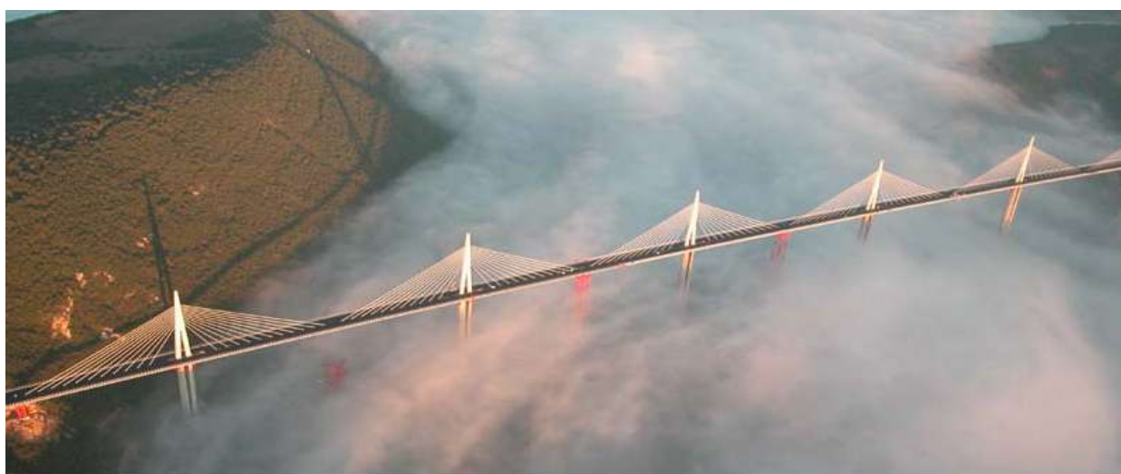
Le Pont de Millau
